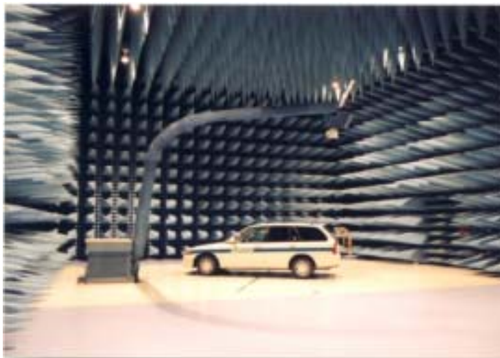
《 写真 》 完成した車輻用電波測定サイト 内部
