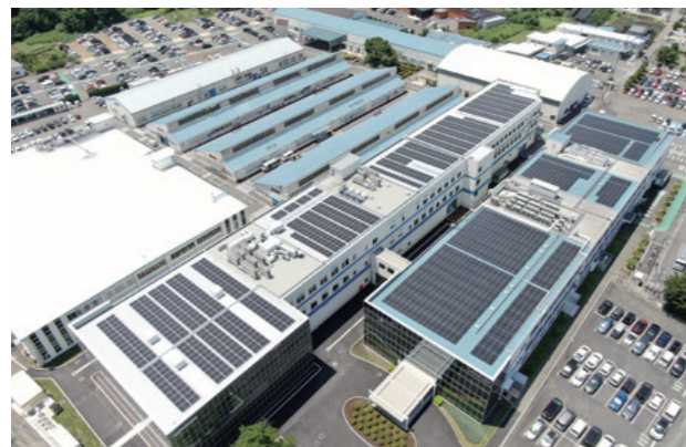
富岡工場2カ所目の太陽光パネル(写真中央建物)
