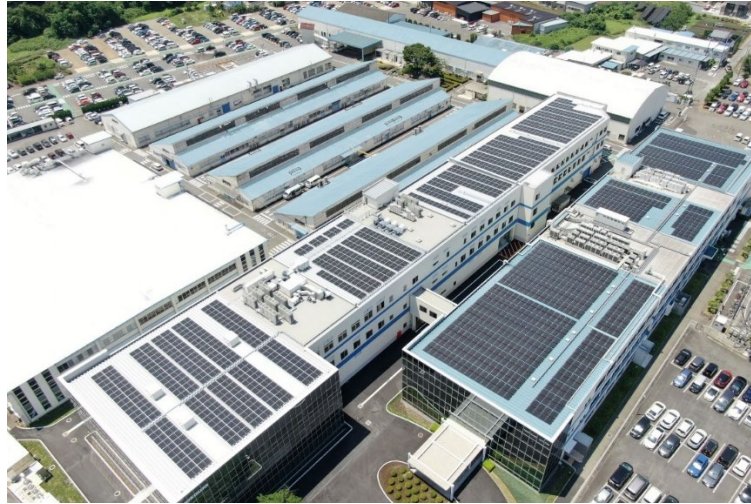
富岡工場に設置された太陽光パネル(群馬県富岡市)
