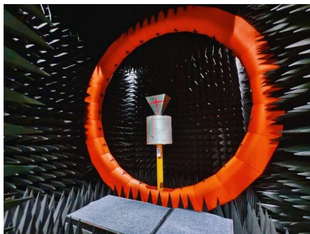
新設した電波暗室
